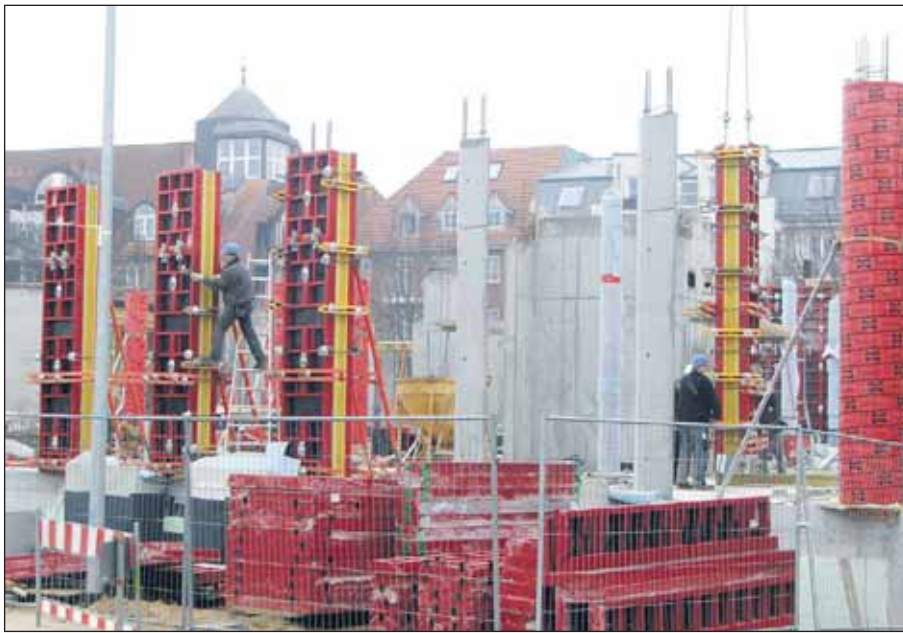
Auf der Baustelle wird gegen die Zeit gearbeitet – ein Sieg ist nicht in Sicht. Foto: StK
